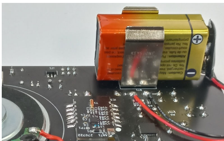
Abbildung 12: Montage der Batterieklemme und der Batterie.
